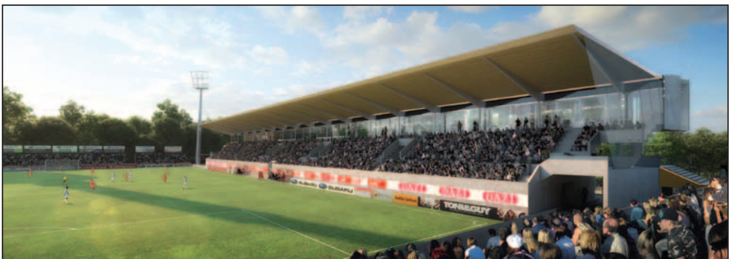
Der Blick vom G-Block auf die neue Haupttribüne (Bilder: Animation ASP-Architekten Stuttgart)
