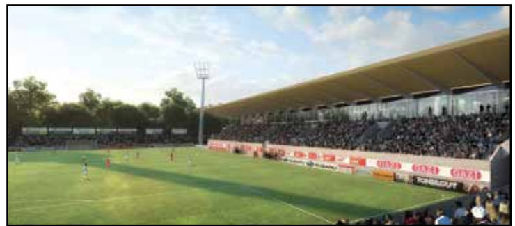
Sicht auf die neue Haupttribüne.
